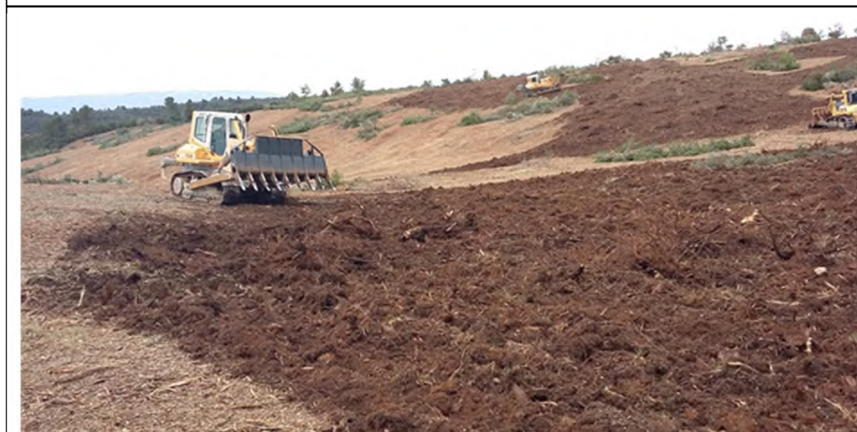
PHOTOGRAPHIE 5 : EXEMPLE DE LA TECHNIQUE DU GRIFFON EN COURS DE DESSOUCHAGE
