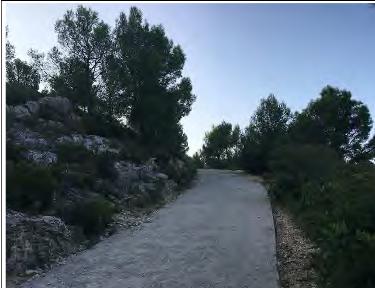
Piste DFCI de la Jarre traitée en béton de site, pente > 20%, Parc National des Calanques (source photographie : TEM paysages)
