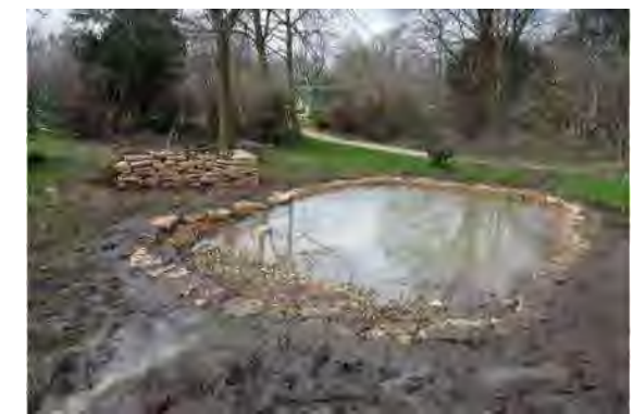
Mare avec berges en blocs de pierres et mur en pierre sèche Source : LPO
