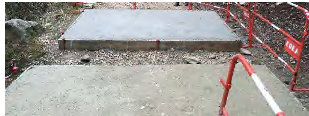
Planches d'essai couleur réalisées en amont des travaux
