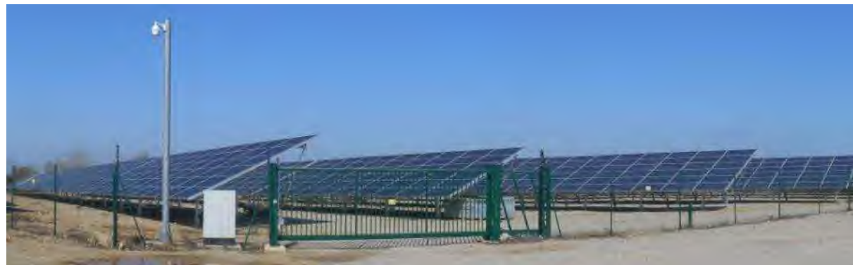
FIGURE 41 : EXEMPLE DE SSYSTÈME DE SÉCURITÉ MIXTE: CAMÉRAS SUR MATS
