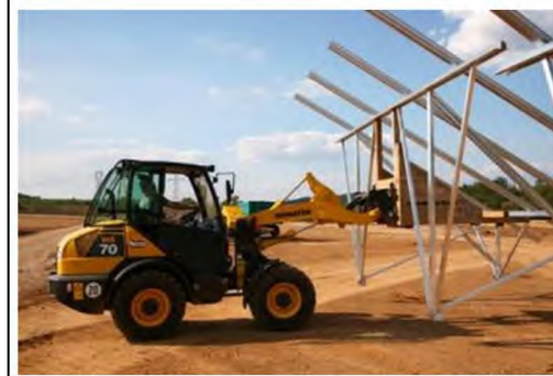
PHOTOGRAPHIE 4 : PHASE CONSTRUCTION SUR LE SITE
