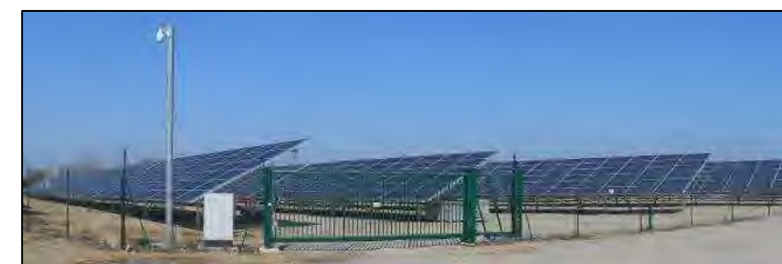
Système de sécurité mixte : caméras sur mât
