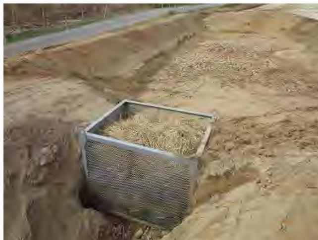
Exemples de bassin de rétention/filtration équipé d'un filtre à paille. ECOTER, 2016.
