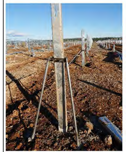
PHOTOGRAPHIE 1 : EXEMPLE D'ENCRAGE DES PANNEAUX – ESPARRON DE PALLIERES
