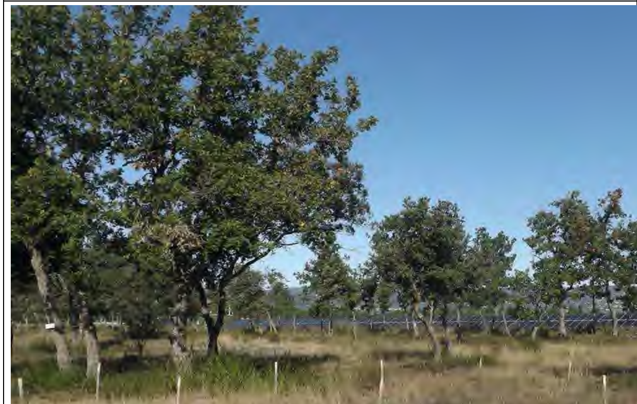
Parc photovoltaïque Engie des Coteaux de Rousset, Gréoux-les-Bains
