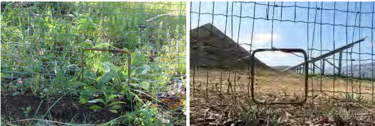
Trouées renforcées créées sur la clôture d’un parc photovoltaïque – DRYOPTERIS, 2018
