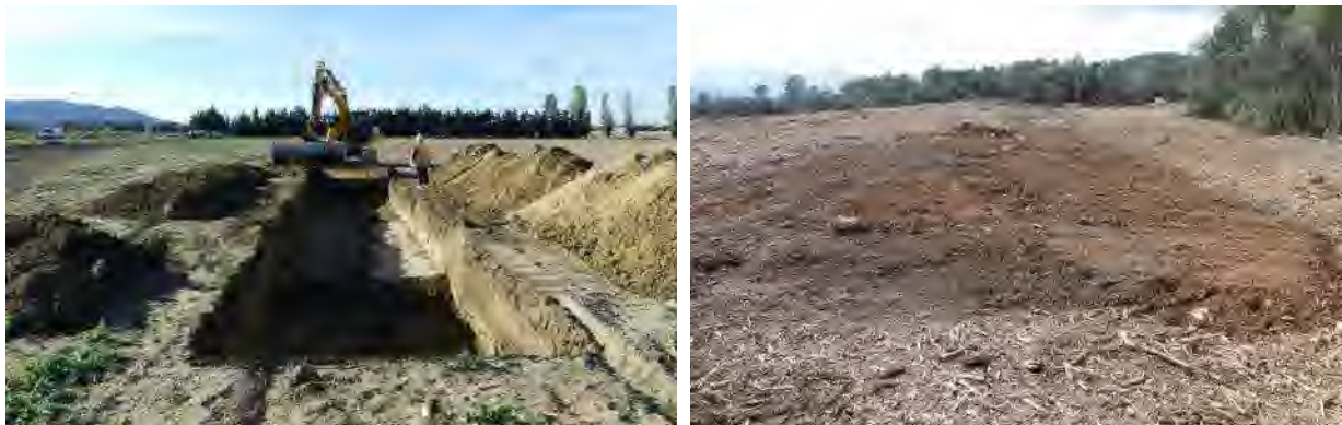
Exemple : la terre végétale est dissociée du sol profond lors du creusement des fouilles (à gauche), puis les horizons sont repositionnés dans leur ordre naturel (à droite). DRYOPTERIS, 2017
