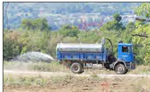
Humidification des pistes d'accès à l'aide d'un camion-citerne
