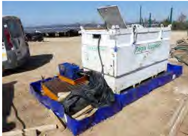
Tous les contenants de produits polluants doivent être placés sur des bacs de rétention ou sur une plateforme étanche adaptée - DRYOPTERIS, 2017
