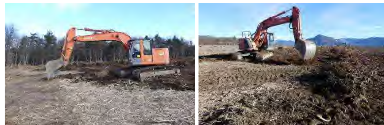
Retrait des souches par peignage superficiel du sol à l'aide de pelles mécaniques équipées de godets à dents. Puis andainage des souches extraites avant le broyage.
