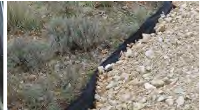
Géotextile placé sous une surface empierrée temporairement - DRYOPTERIS, 2017
