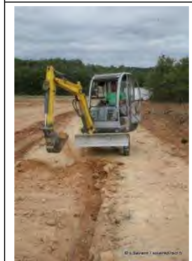
FIGURE 5 : REALISATION DES TRANCHEES
