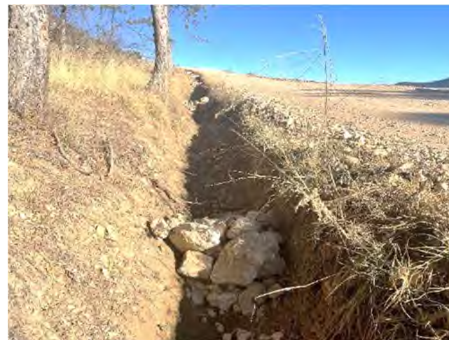
Exemple de fossés de récupération des eaux pluviales équipés de filtre empierré brise débits. ECOTER, 2016
