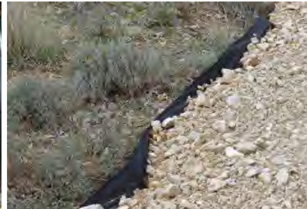
Géotextile placé sous une surface empierrée temporairement
