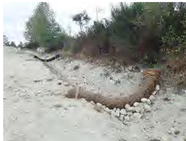
Exemple de fossés de récupération des eaux pluviales équipés de filtre empierré brise débits. ECOTER, 2016
