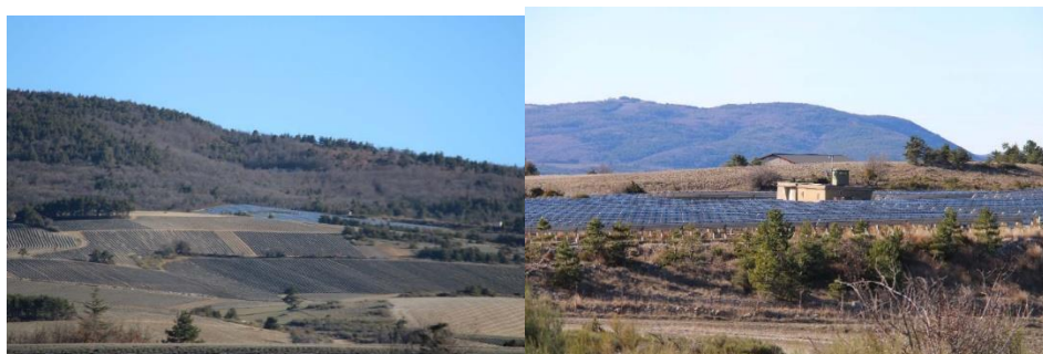
Figure 73 : Parcs photovoltaïques sur les contreforts de la montagne d'Albion et au milieu des lavandes à proximité de la RD189 (Ferrassières)
